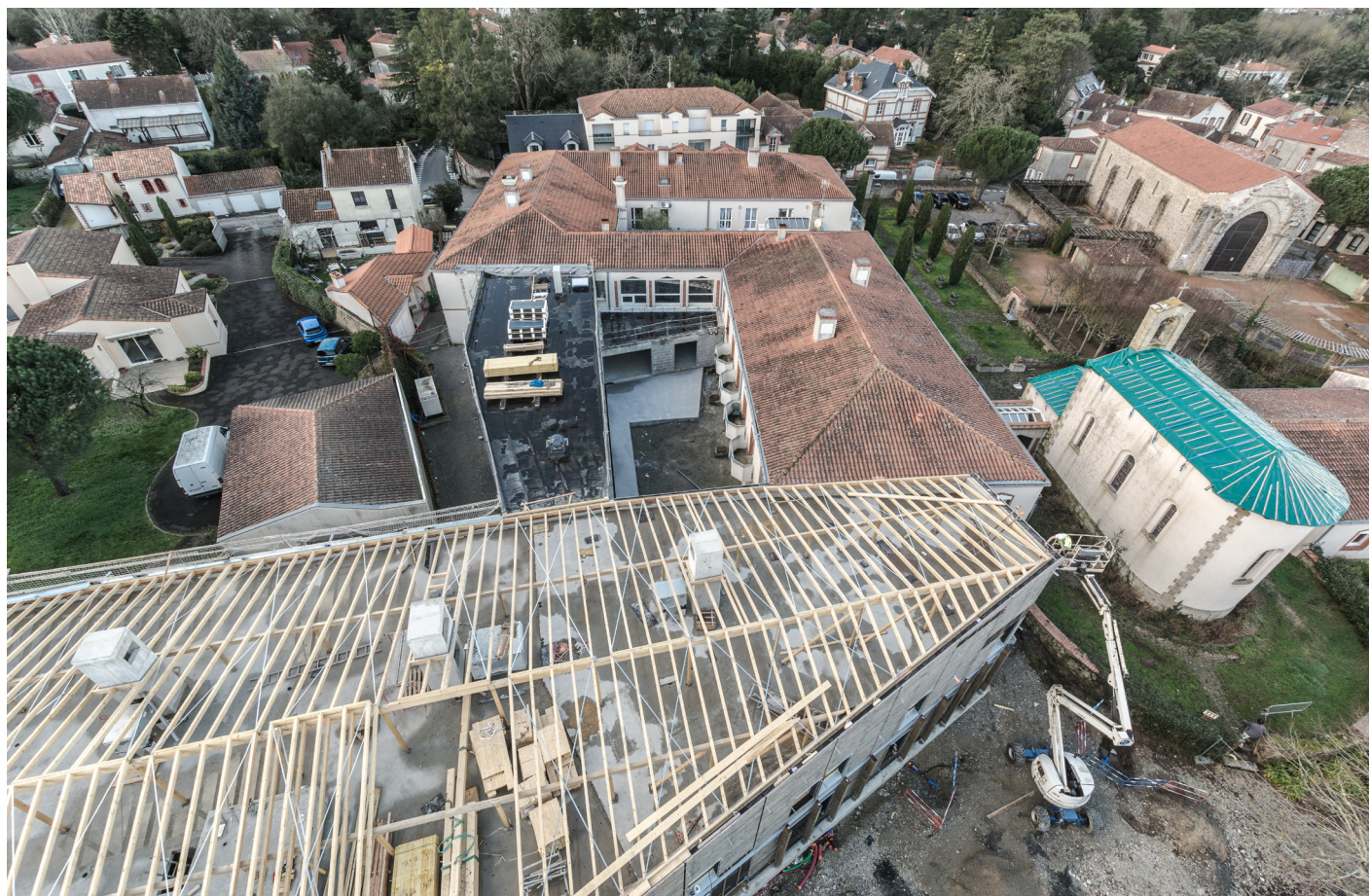
▼ Extension en cours
